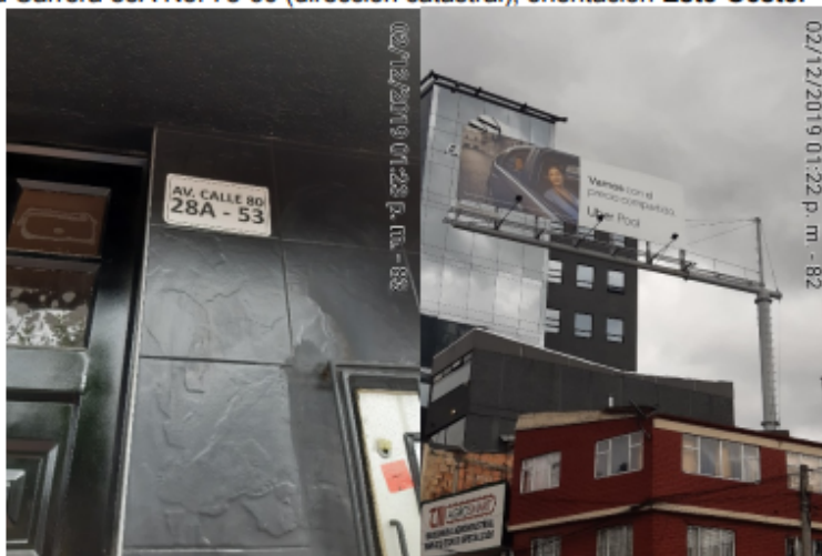
Foto No. 3 y 4: Nomenclatura del predio y vista panorámica del panel y de la estructura de la valla, en buenas condiciones y estable, ubicada en la Av. Calle 80 No. 28A-53 (dirección catastral), orientación Oeste-Este , sitio del traslado.
