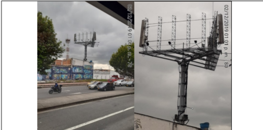
Foto No.1 y 2: Vista panorámica del predio, del panel desmontado y de la estructura de la valla ubicada en la Carrera 85A No. 78-60 (dirección catastral), orientación Este-Oeste .
